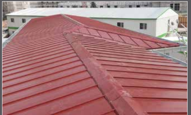
MFA İNŞAAT - EMNİYET GENEL MÜDÜRLÜĞÜ İNŞAATI
