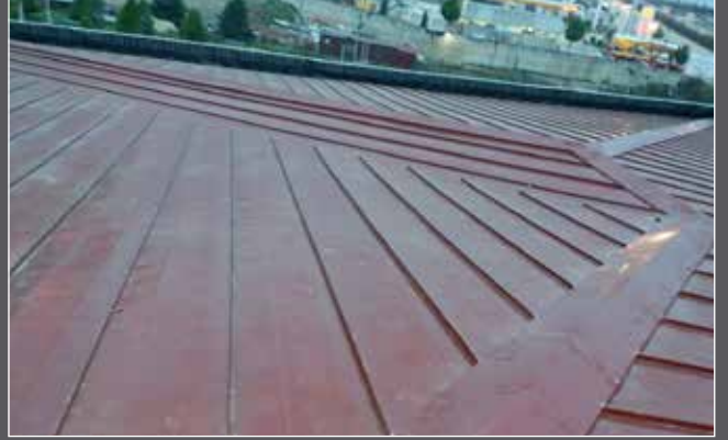
AKÇE İNŞAAT - GİRESUN ADLİYE SARAY
