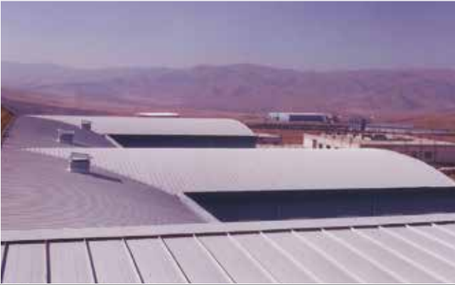
PEKERLER İNŞAAT - KIRIKKALE ÜNİVERSİTESİ KAMPÜSÜ
