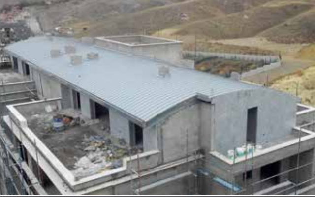
ADEN İNŞAAT - YAŞAMKENT KONUT İNŞAATI
