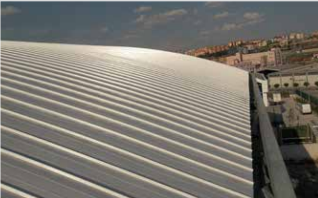
MAN İNŞAAT - BATIKENT NEVA KOLEJİ
