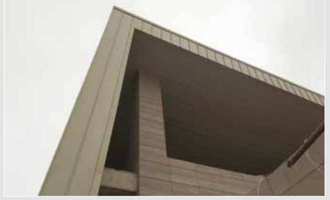
MBD İNŞAAT - GÖLBAŞI DEPO İNŞAATI
