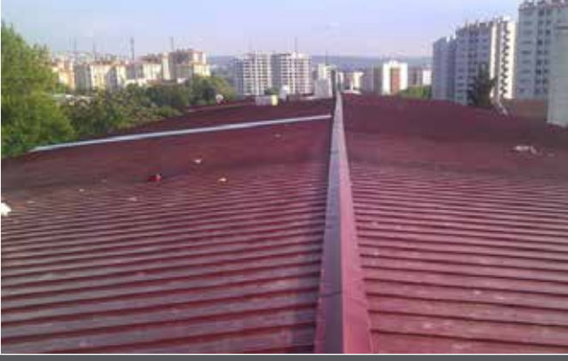
TEMELFEN - TARIM BAKANLIĞI STÜDYO İNŞAATI
