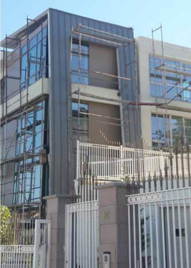
ANADOLU ENERJİ - ÜMİTKÖY İŞ YERİ İNŞAATI
