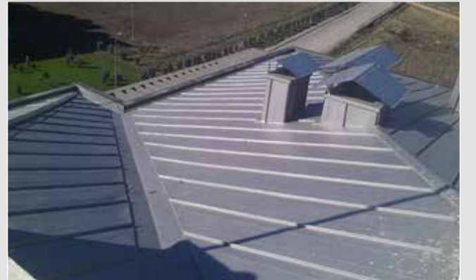
MAZZ İNŞAAT - GÖLBAŞI KONUT İNŞAATI
