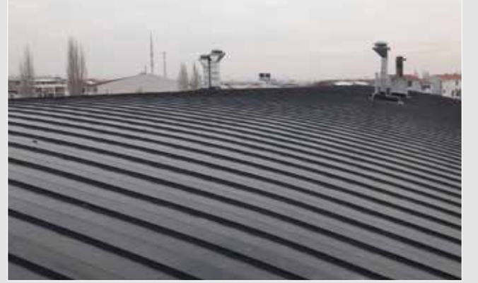
RİKA İNŞAAT - ÇUBUK İTFAİYE İNŞAATI
