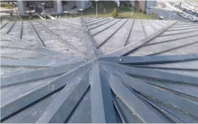
PERDE İNŞAAT - NEŞET ERTAŞ KÜLTÜR MERKEZİ PROJESİ
