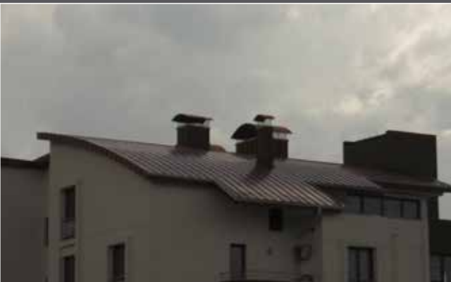
SİRYA İNŞAAT - ÇAYYOLU KONUT İNŞAATI
